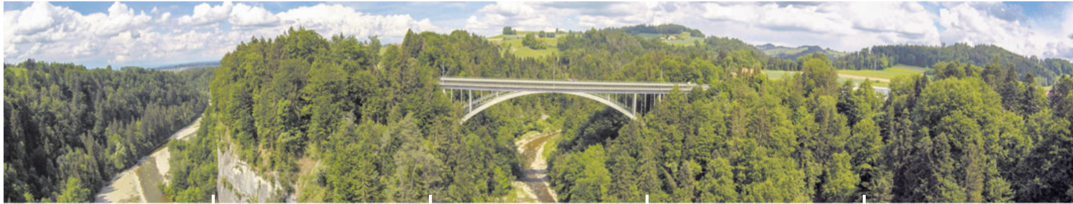
Peter Hofmann Foto: Schwarzwasserbrücke
