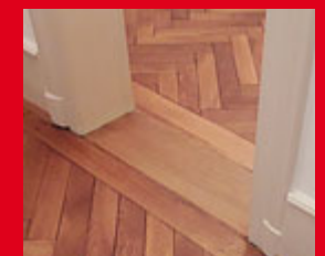
Abbau von Schwellen
